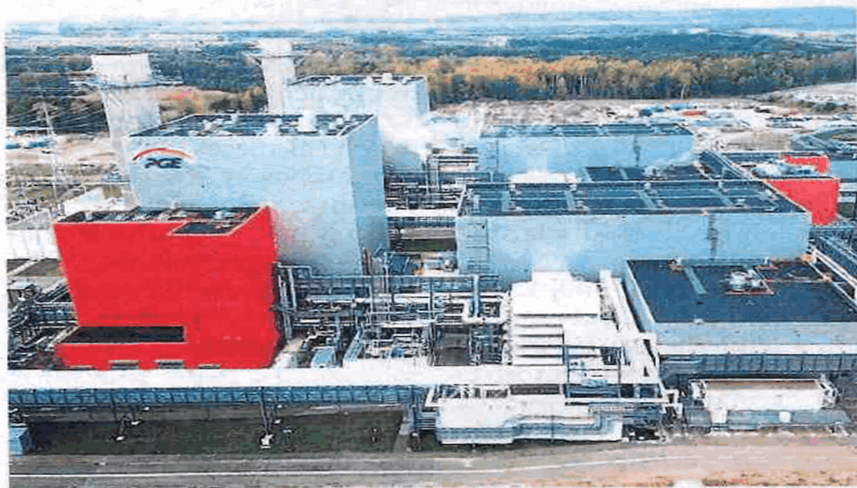
PGE Polska Grupa Energetyczna uruchomiła w Gryfinie największą elektrownię gazową w Polsce
